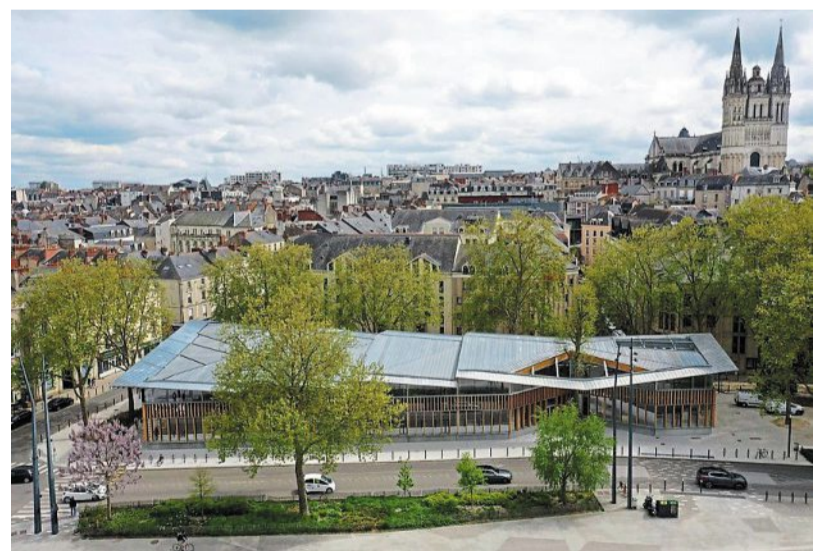
Le bâtiment se déploie en longueur, tout en offrant une hauteur sous plafond qui rappelle le style des halles alimentaires.
